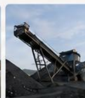
HỆ THỐNG BĂNG TẢI
